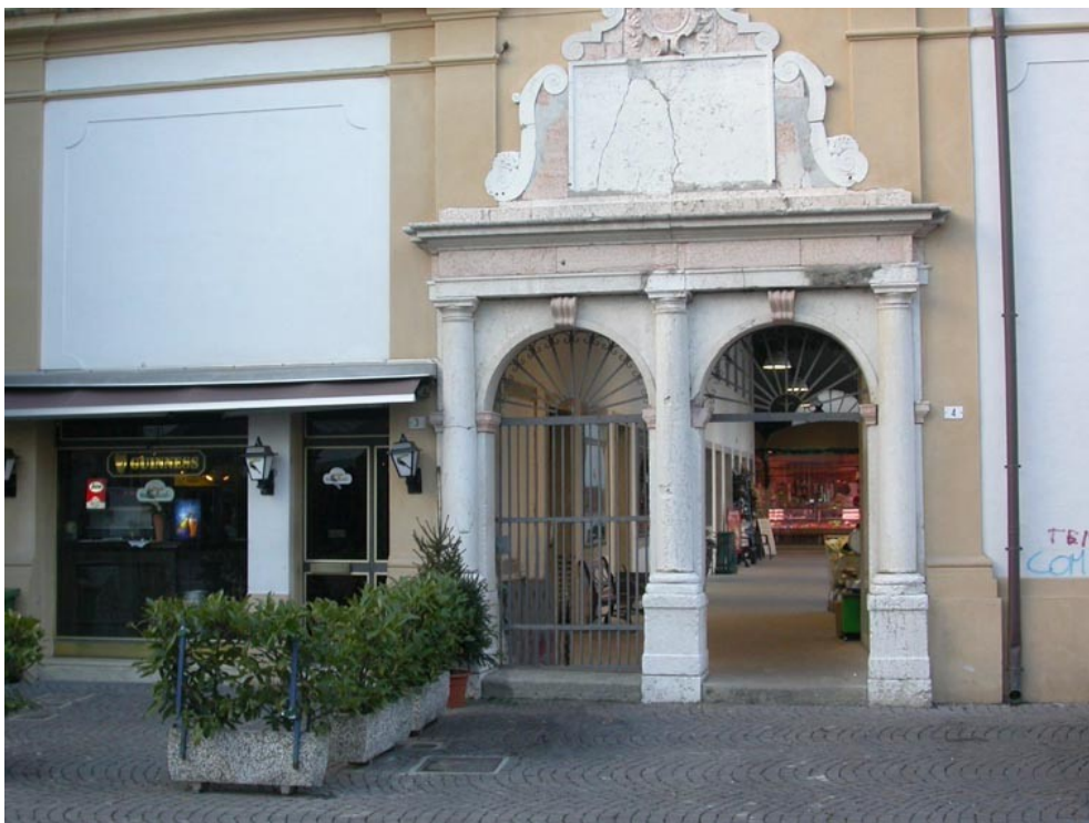
Portale d'accesso al ghetto in via X luglio poi spostato all'ingresso pedonale, a sud, del mercato anonario
